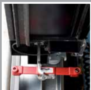
.Leading Safety Beam´ – ruchoma fotokomórka bezpieczeństwa
